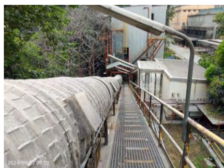
รูปที่ 2-74 หลังคาปิดคลุมของระบบสายพาล้ำเลี้ยง Solid waste
