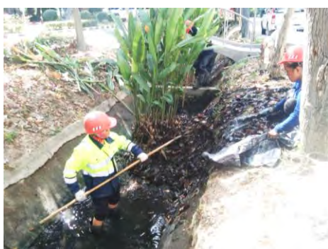
รูปที่ 2-27 การทำความสะอาดและขุดลอกตะกอนในระบบระบายน้ำ
