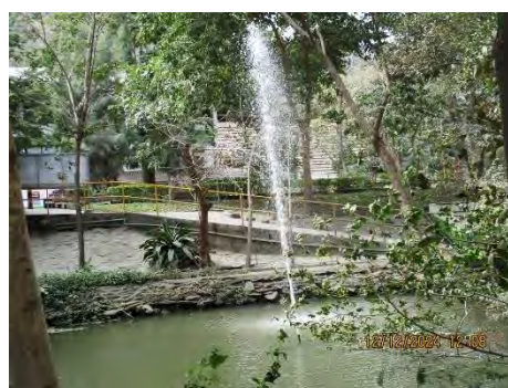
รูปที่ 2-18 ระบบเติมอากาศเพื่อเพิ่มออกซิเจนในบ่อพักน้ำก่อนนำไปใช้
