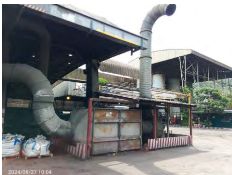
ระบบ Activated Carbon บริเวณถังเก็บ Liquid Waste โรงงาน 2 และ 3
