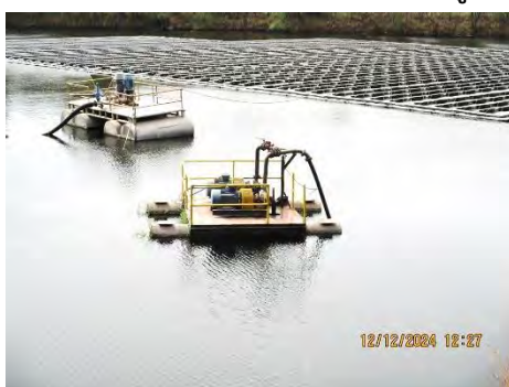
รูปที่ 2-18 ระบบเติมอากาศเพื่อเพิ่มออกซิเจนในบ่อพักน้ำก่อนนำไปใช้
