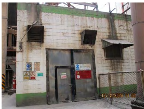
รูปที่ 2-11 อาคารปิดคลุมเครื่องจักรที่มีเสียงดังโรงงาน 2 และ 3 (ต่อ)
