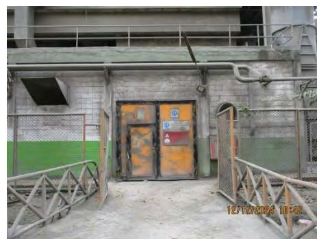
รูปที่ 2-11 อาคารปิดคลุมเครื่องจักรที่มีเสียงดังโรงงาน 2 และ 3
