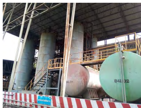
รูปที่ 2-72 ระบบบำบัดกลิ่น/ไอบริเวณถังเก็บและบริเวณที่จัดรถบรรทุกสำหรับขนถ่าย Liquid waste
