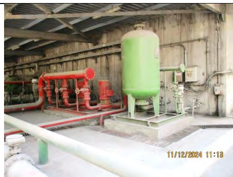
รูปที่ 2-15 ระบบการนำน้ำจากระบบหล่อเย็นกลับมาใช้ใหม่
