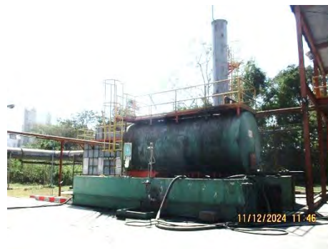
ระบบ Activated Carbon บริเวณถังเก็บ Liquid Waste โรงงาน 2 และ 3
