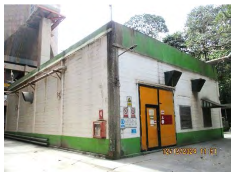
รูปที่ 2-11 อาคารปิดคลุมเครื่องจักรที่มีเสียงดังโรงงาน 2 และ 3
