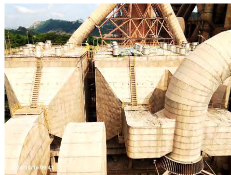
รูปที่ 2-2 เครื่องดักฝุ่นแบบ Electrostatic Precipitator ของโรงงาน 2 และ 3
