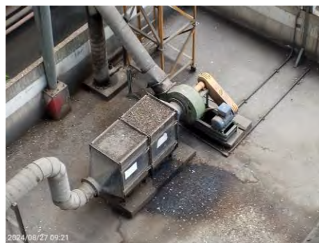
ระบบ Activated Carbon บริเวณถังเก็บ Liquid Waste โรงงาน 2 และ 3
