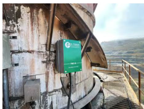
รูปที่ 2-10 ระบบ CEMS ของโรงงาน 2 และ 3
