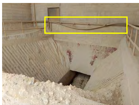
รูปที่ 2-1 อาคารรับวัตถุดิบ ม่านยางและการสเปรย์น้ำบริเวณจุดขนถ่ายวัตถุดิบ โรงงาน 2 และ 3
