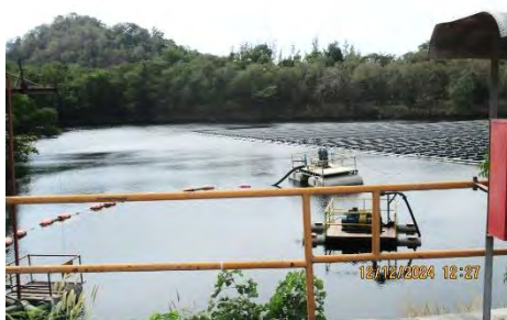
รูปที่ 2-19 บ่อเก็บกักเพื่อนำน้ำมาใช้หมุนเวียน
