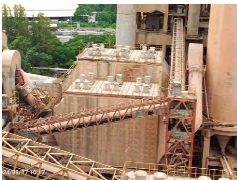
รูปที่ 2-2 เครื่องดักฝุ่นแบบ Electrostatic Precipitator ของโรงงาน 2 และ 3
