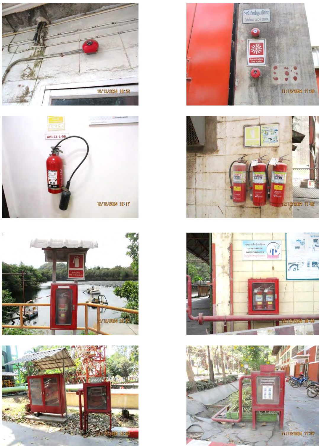
รูปที่ 2-62 ระบบสัญญาณเตือนภัยไฟไหม้และอุปกรณ์ดับเพลิง
