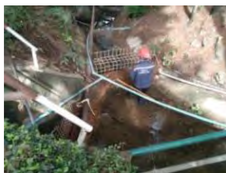
รูปที่ 2-27 การทำความสะอาดและขุดลอกตะกอนในระบบระบายน้ำ
