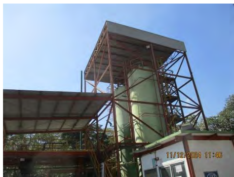
ระบบ Activated Carbon บริเวณถังเก็บ Liquid Waste โรงงาน 2 และ 3
